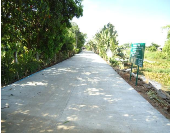
รูป 1.1 ก่อสร้างถนน คสล. ม.5
