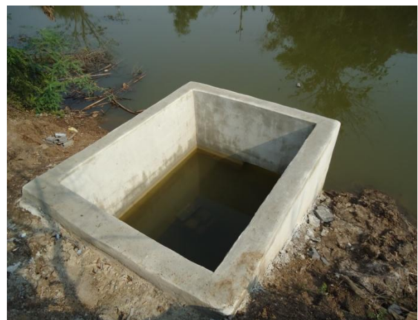
รูป 1.4 ก่อสร้างอ่างพักน้ำ ม.1
