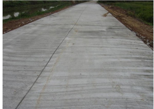
รูป 1.2 ก่อสร้างถนนคสล. ม.2
